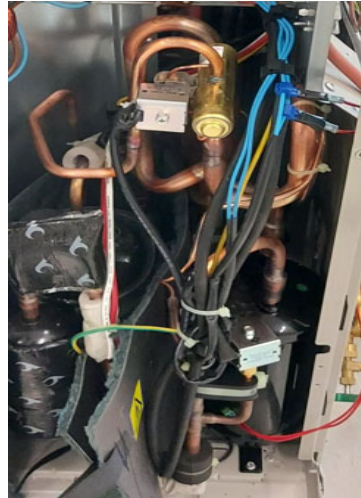
Kältekreis (refrigerant circuit)
