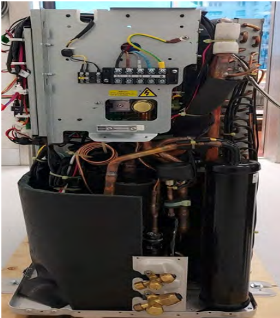
Kältekreis (refrigerant circuit)
