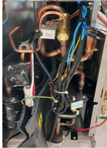
Kältekreis (refrigerant circuit)
