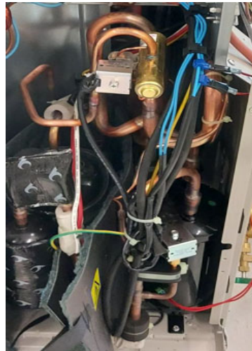
Kältekreis (refrigerant circuit)
