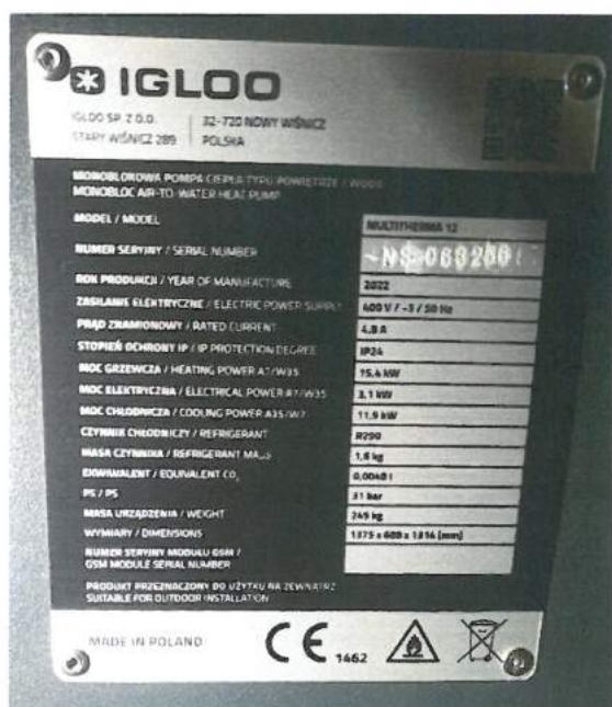
Fot. 1 Błędna tabliczka znamionowa Fig. 1 Incorrect nameplate
