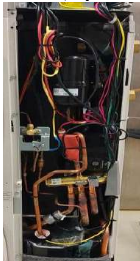
Kältekreis (refrigerant circuit)
