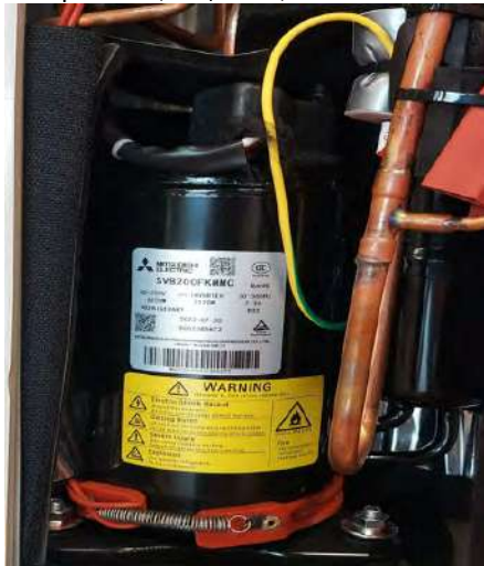
Kompressor (Compressor)
