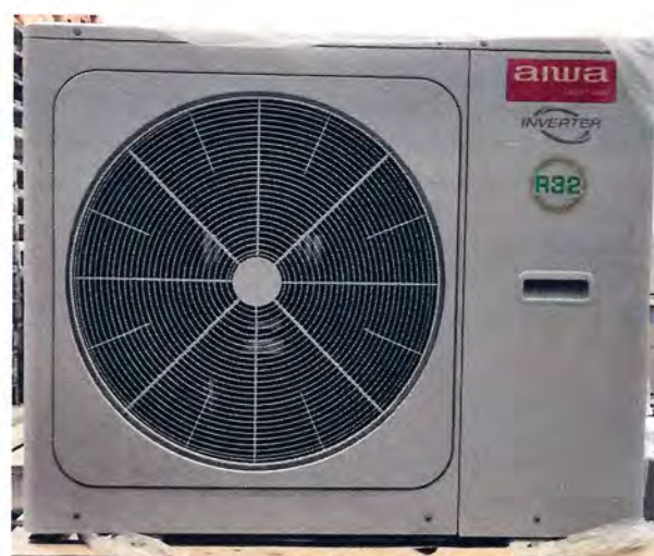
/ Zdjęcie 5: Pompa ciepła: AIWA (MANTA)
