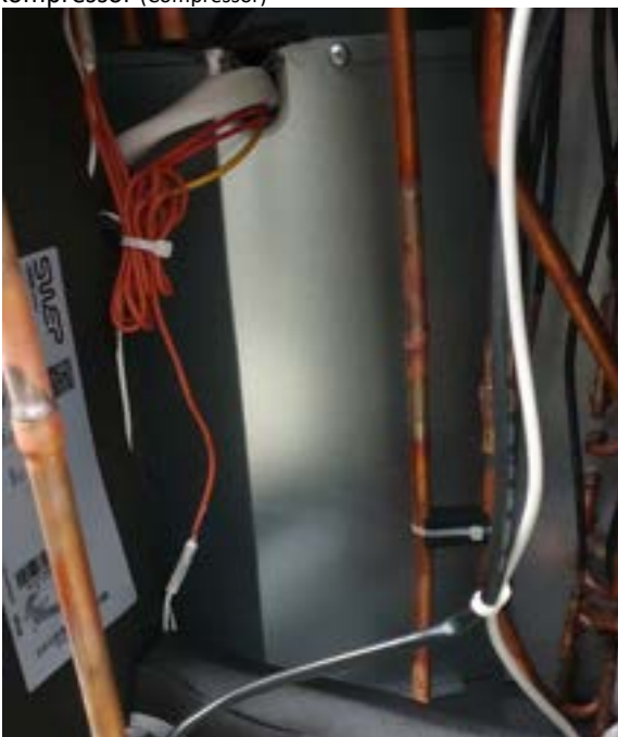
Kompressor (Compressor)
