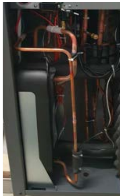
Kältekreis (refrigerant circuit)
