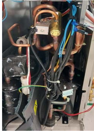
Kältekreis (refrigerant circuit)
