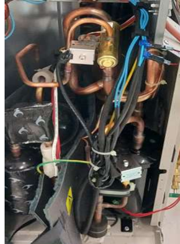
Kältekreis (refrigerant circuit)
