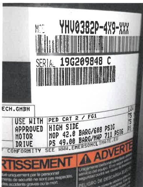
Tepelné čerpadlo Calla Verde M 20 – štítek kompresoru –
