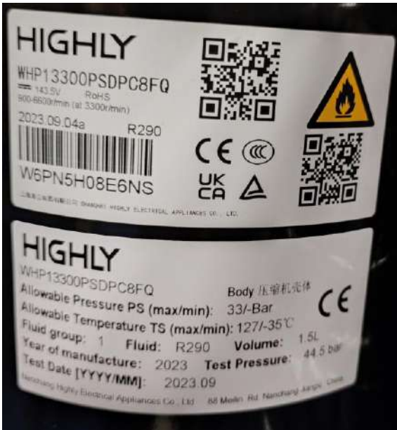
Bild 4 / Picture 4 Typenschild Verdichter Name plate compressor
