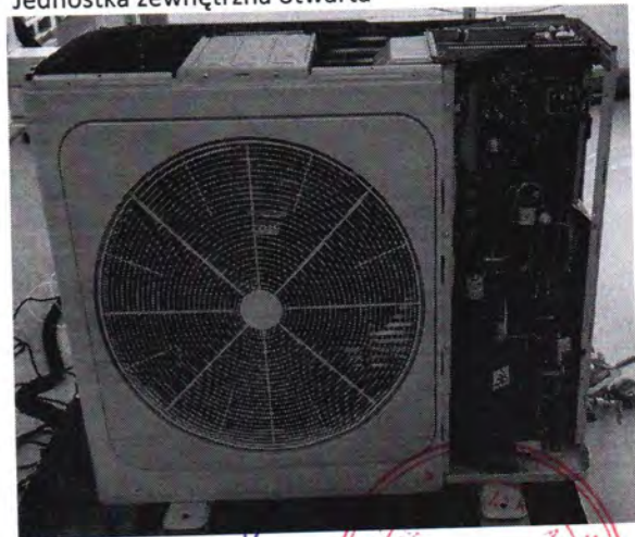
Jednostka zewnętrzna otwarta
