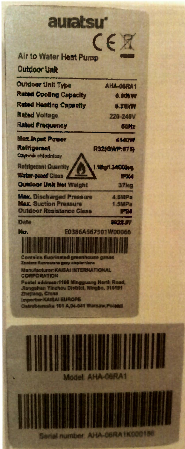
Fot. 6 Poprawne tabliczki znamionowe jednostki zewnętrznej Photo 6 Correct nameplates outdoor unit
