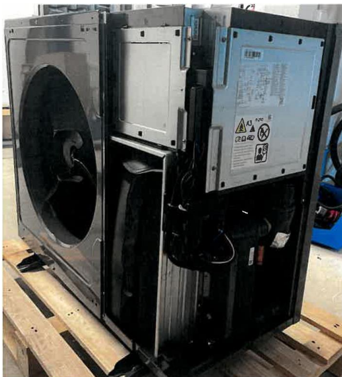
Pompa ciepła AE080CXYDGK/EU – jednostka zewnętrzna - Bez pokrywy -
