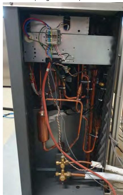
Kältekreis (refrigerant circuit)
