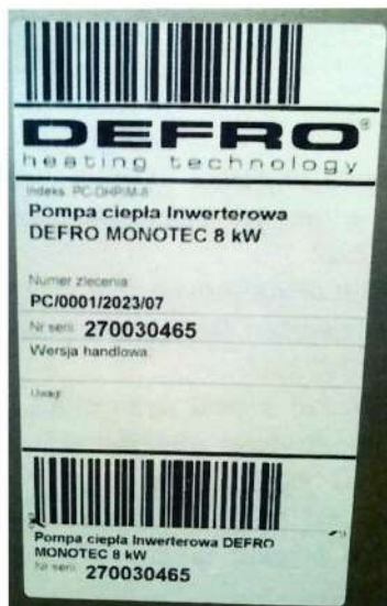
Fot. 3 Błędna tabliczka znamionowa Fig. 3 Incorrect nameplate
