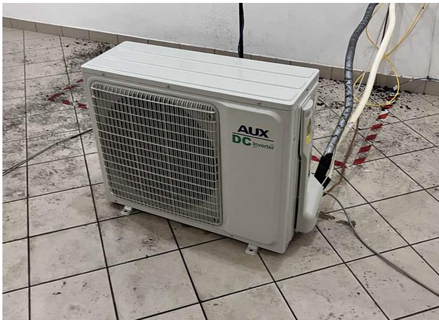
Figure 4 - Panoramic of installation in the external room (Rysunek 4 - Panorama instalacji w pomieszczeniu zewnętrznym).
