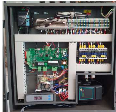
Elektrische Einheit IDU (Electrical unit IDU)
