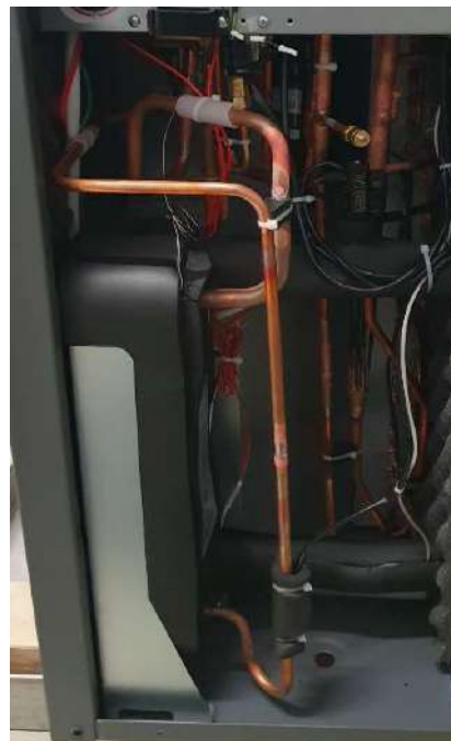
Kältekreis (refrigerant circuit)
